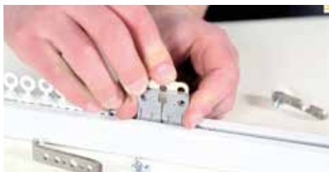
Étape 6 : On la glisse totalement dedans pour que les 2 trous coïncident avec les trous du conducteur.
