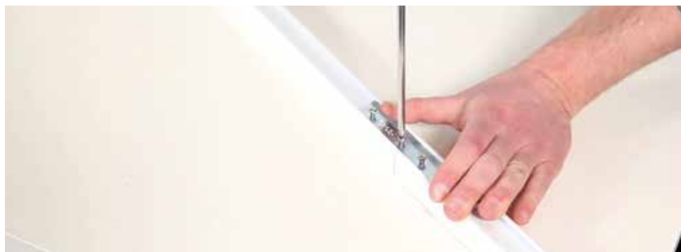
Étape 4 : On glisse le raccord pour le mettre à cheval sur les 2 tringles et l'on vis sans trop forcer.
